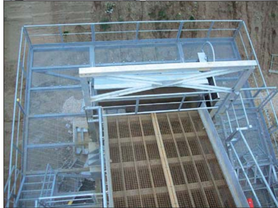
Protection périphérique étage supérieur
