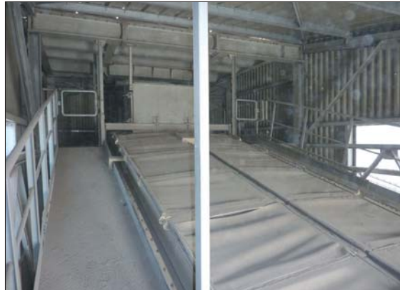
Passerelles d'accès à l'étage supérieur
