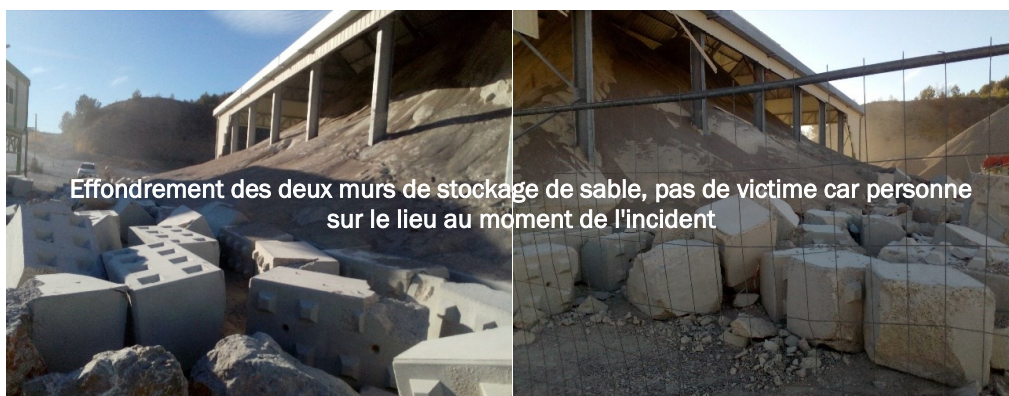
Effondrement d'un mur de stockage de sable, pas de victime car personne sur le lieu au moment de l'incident
